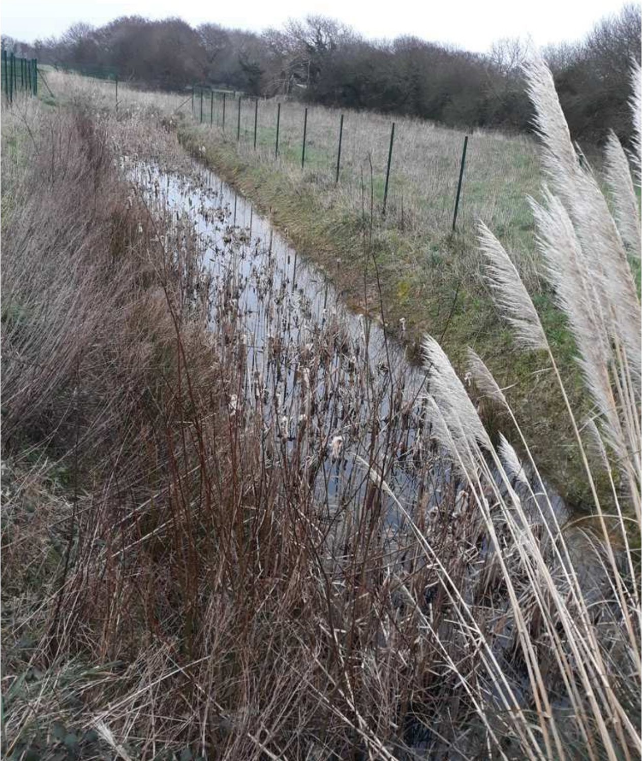
Exemple de noue plantée (© EGEO 2020)
